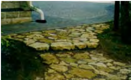
Дорожка из рваного камня с гранитным заполнением
