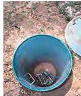
Кессон напоминает стальную бочку, зарытую в землю, со съёмной крышкой.
