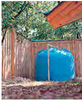
Полиэтиленовая накопительная ёмкость объёмом 4500 л используется для хранения и отстоя воды для полива.
