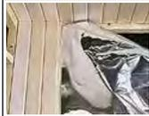
Между элементами каркаса закладывают утеплитель. С внутренней стороны парилки его закрывают фольгой.
