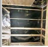
Смонтированный на бетонной стене, каркас плотно прижимает к ней пергамин.
