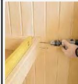
Крепление висящей сдвоенной доски к торцу каркаса лавки.
