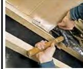
Первым обшивается потолок. Вагонка прибивается потайным гвоздем в паз или, как показано здесь, в гребень.
