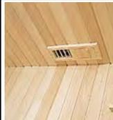
Вытяжное вентиляционное отверстие делают в потолке. В данном случае вентиляционный канал проложили в утеплителе потолка.
